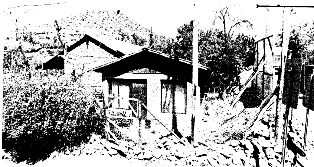
Imagen 4: fachada principal del inmueble.
